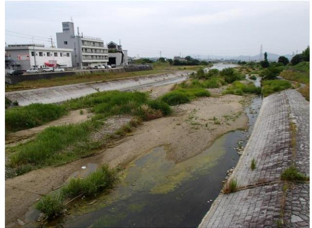
○高橋から見た上流（写真左）と下流（写真右）。兩岸ともハードなコンクリート護岸となっている。
