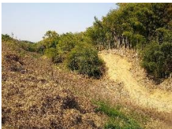
太陽光パネル周辺の造成地
