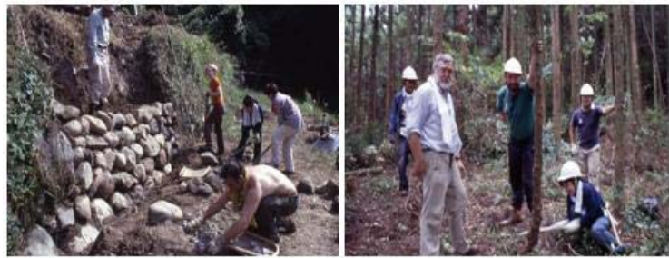
写真-8 福岡県八女市黒木町で 1997 年より継続される国際里山・田園保全ワーキングホリデー
