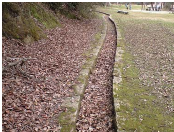
図8 芝生広場に設置された三面張りの水路
