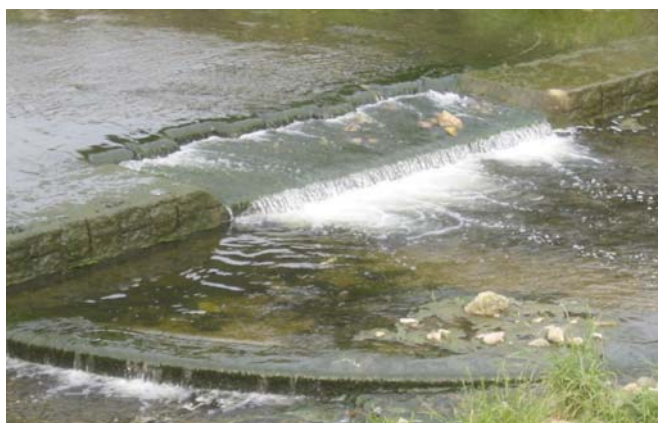
写真-21 工夫されているが、流れが跳水状態
