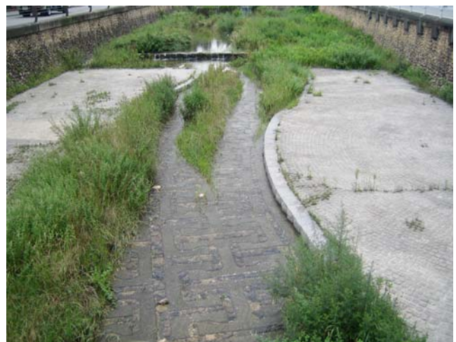
写真-17 化粧石張りの河床と洪水に耐える植性
