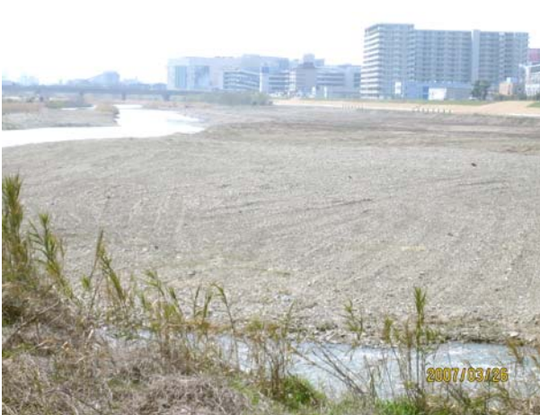
写真-11 平坦化への切下げ直後
