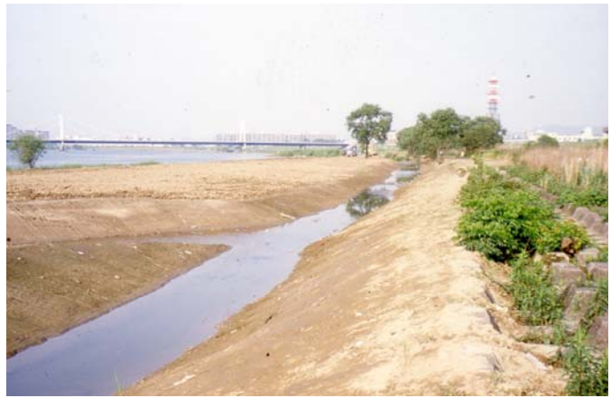
写真-10 工事直後の城北寄り州の切下げ
