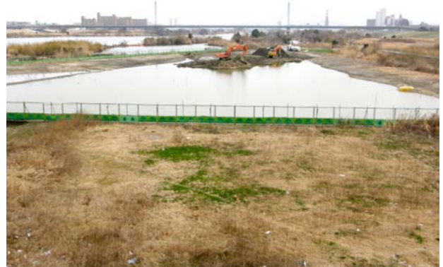
写真-14 工事中の赤川ワンド
