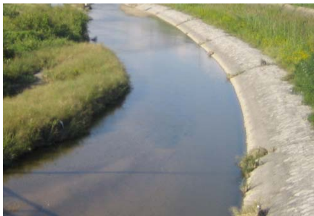
写真-1 水域と陸域を分断する低水護岸
