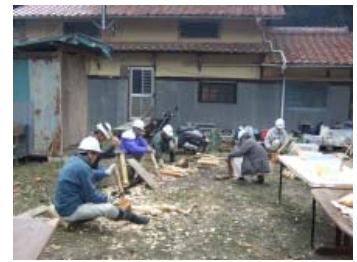
観察路の修復（杭づくり）
