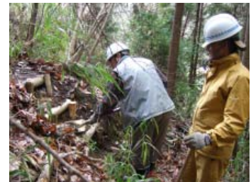
観察路の修復（階段づくり）
