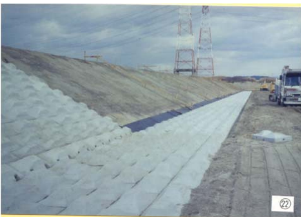
写真-7 施工中の隠し護岸: この上に 1m の覆土
