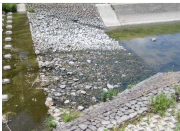
写真-19 斜路型の全面魚道
