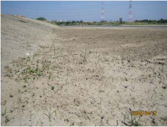
写真-9 工事直後の鶴殿切下げ
