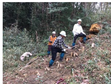
観察路補修作業
