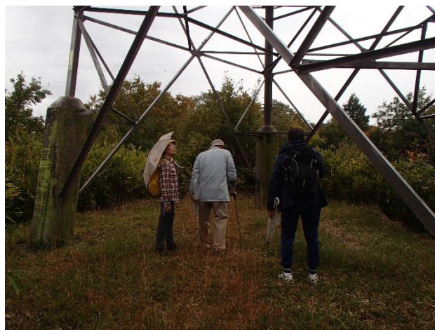
○鉄塔の下は管理されて開けている。
