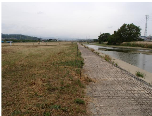
○川西大橋下流の市営グラウンド付近の護岸は、天端部および法面がコンクリートになっており、グラウンドがすぐに接しているため、河川敷の川原や草地環境の連続性が見られない。
