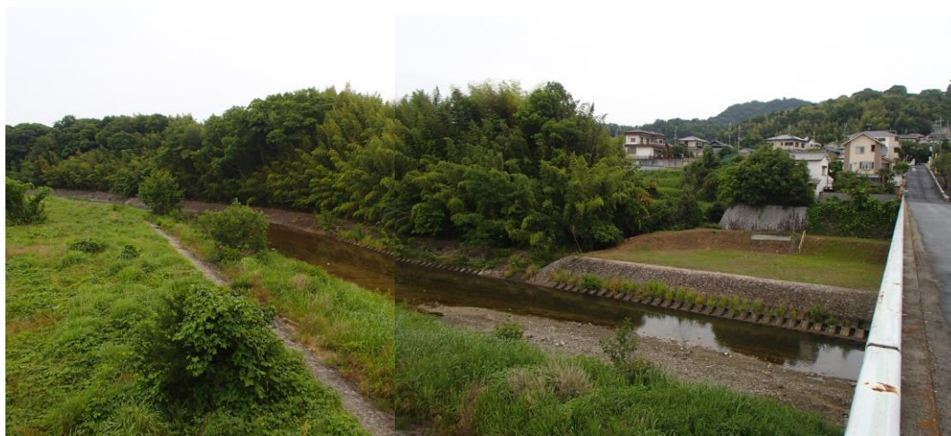
○千代田橋から下流側を見る。右岸の護岸下部は草の生える自然護岸が採用されている。 川岸にせまる樹林・竹林はホタルの生息地となっている。
