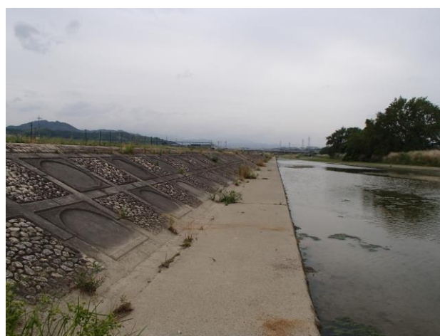
○川西大橋下流の市営グラウンド付近の護岸は、天端部および法面がコンクリートになっており、グラウンドがすぐに接しているため、河川敷の川原や草地環境の連続性が見られない。
