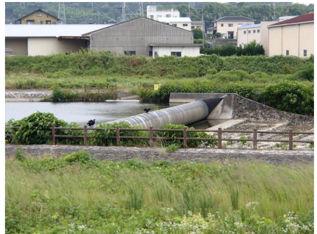
○深溝井堰に設置されたラバーダム（ゴム製堰）※で止水域ができています。
