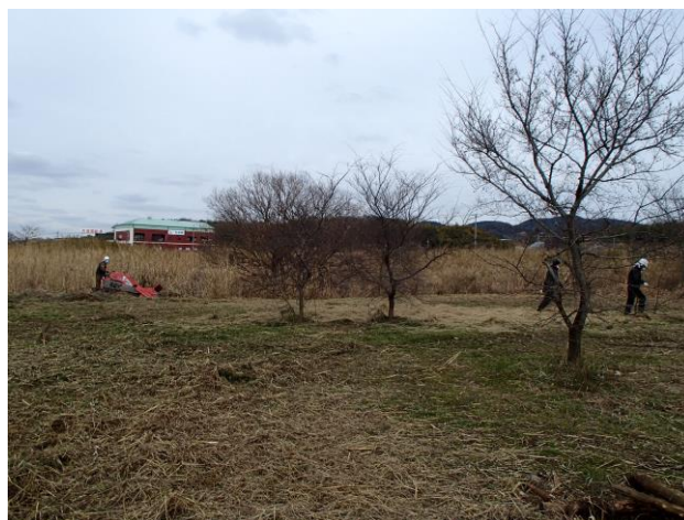
○増水時に問題となる大きく成長した樹木。 河南橋上流右岸の自然ゾーン B 地区では、比較的小さな灌木類を除草時に伐根した。
