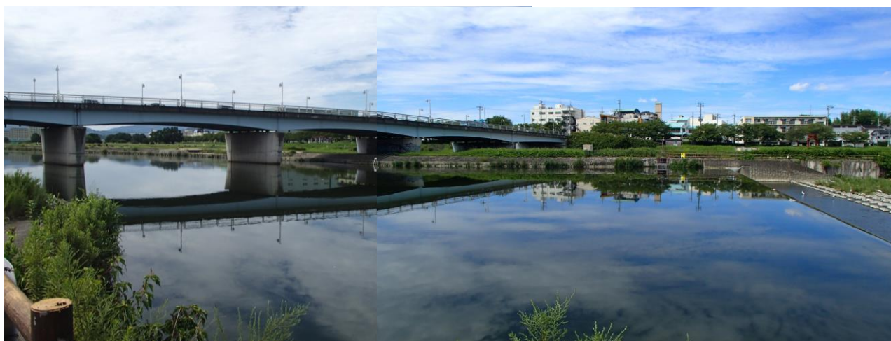
○金剛大橋下流右岸から対岸を見る
