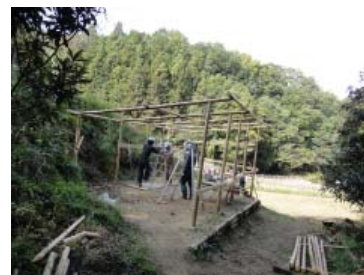
炭焼小屋の建築
