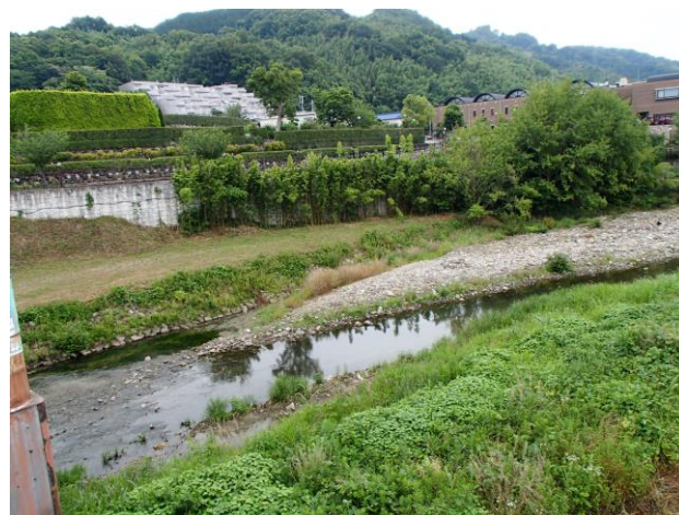
○千代田橋右岸上流側。施設造成で整備されたコンクリート壁は竹で緑化されている。
