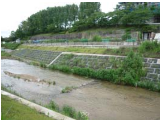
山手町への橋付近の佐備川では、植生の生育に配慮した護岸整備が見られた。
