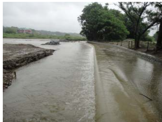
改修された大黒用水路
