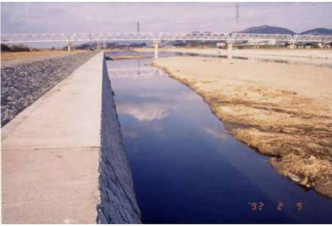
写真1 直線的な低水路護岸が築かれ、高水敷は平坦に整地される
