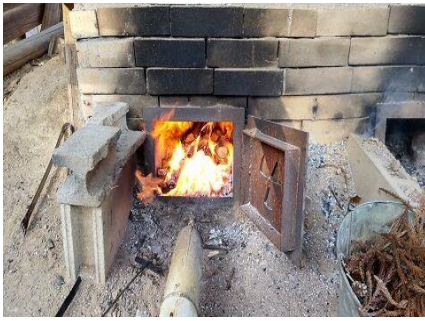
写真 2-a 窯前面 修理前
