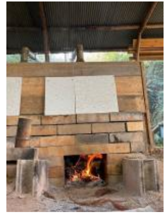
修理後 (レンガ製火口)
