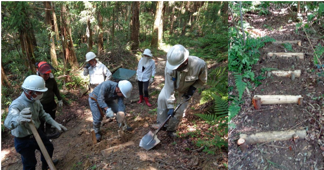
「さとり」対象林に作業路を造成
