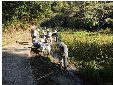
イノシシ柵設置作業
