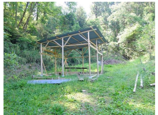
ほぼ完成したバックヤード
