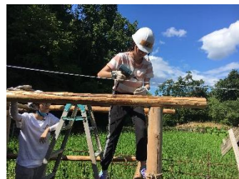
薪小屋建築作業
