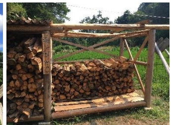
完成した増設部分
